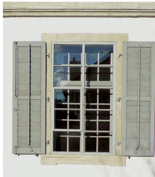
Abb. 1: Rekonstruiertes Vorfenster. Südfassade, Erdgeschoss, Raum Nr. 11.
