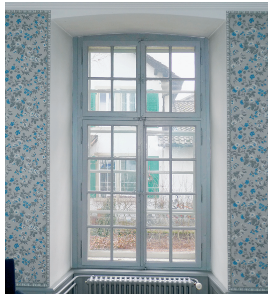
Abb. 2: Konserviertes Innenfenster. Südfassade, Erdgeschoss, Raum Nr. 11.
