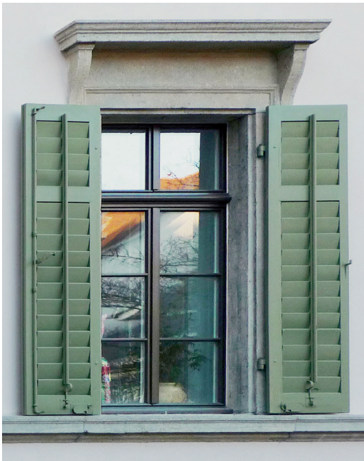
Abb. 2: Fensternachbau mit Isolierverglasung in bauzeitlicher Farbigkeit, Foto 2010. Ostfassade.
