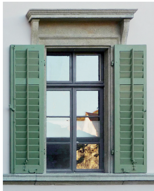
Abb. 1: Originalfenster mit Einfachverglasung in bauzeitlicher Farbigkeit nach der Konservierung im Jahr 2010. Ostfassade.
