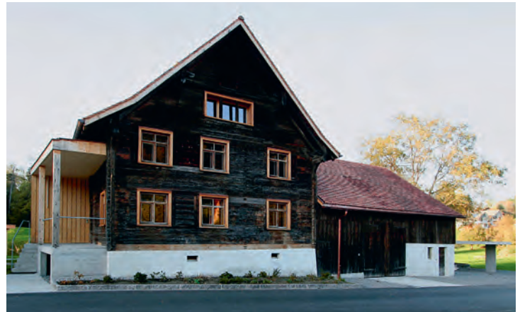
Nach der Sanierung: Nur der neue Anbau am Wohnhaus zeugt aussen vom Umbau.
