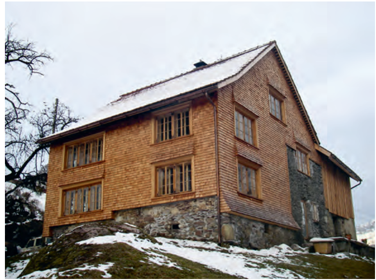
Nord- und Ostfassade nach der Renovation
