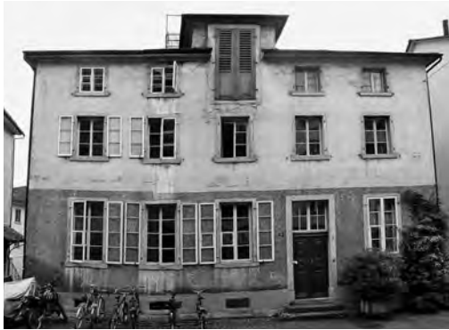
Nordfassade vor der Sanierung
