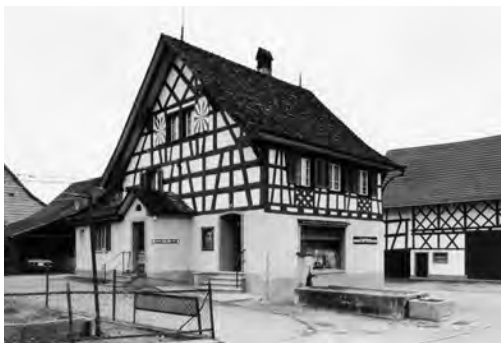
Gebäude vor der Sanierung
