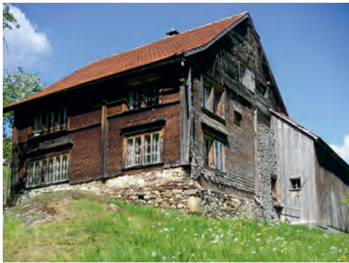
Nord- und Ostfassade vor der Sanierung
