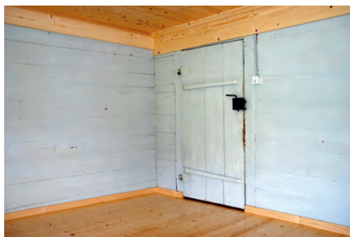
Innenansicht 2: Sichtbare Anschlussarbeiten an die erhöhte Decke
