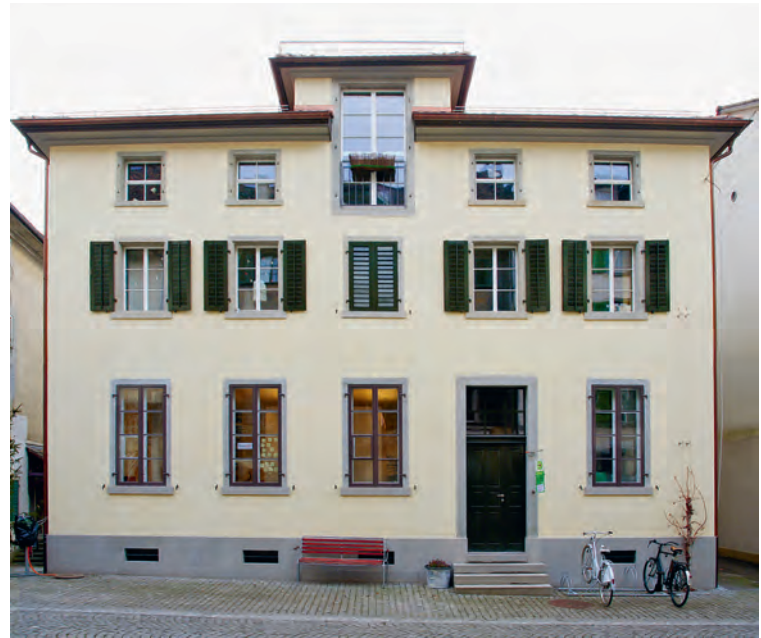
Nordfassade nach der Sanierung
