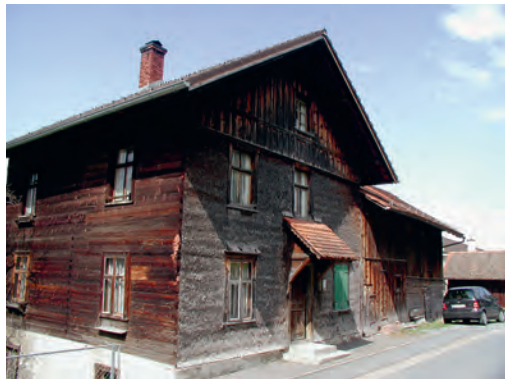
Gebäude vor der Sanierung
