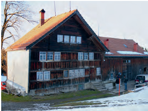
Südfassade vor der Sanierung
