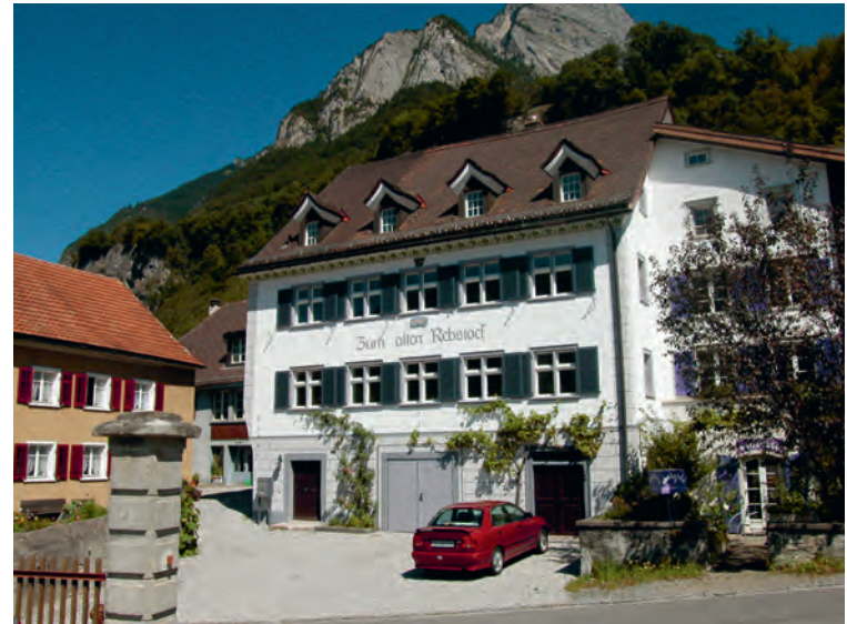
Südfassade nach der Sanierung
