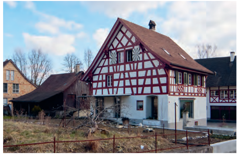
Nach der Sanierung, MINERGIE®-Standard, renovierte Fassade mit Innendämmung.
