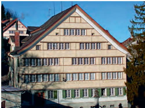
Ostfassade vor der Sanierung
