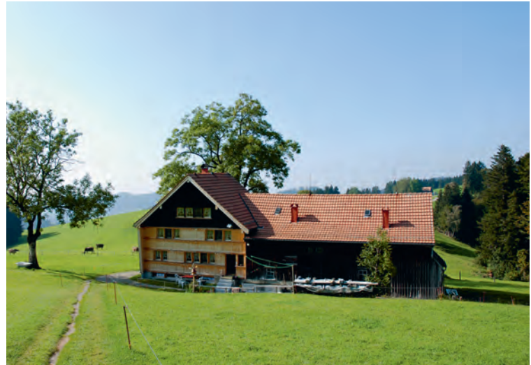
Südfassade nach der Sanierung, neue Vertäferung im Erd- und Obergeschoss
