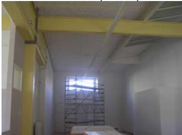
Zustand NACHHER (Decke)
