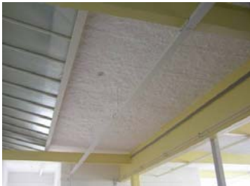
Zustand NACHHER (Decke)
